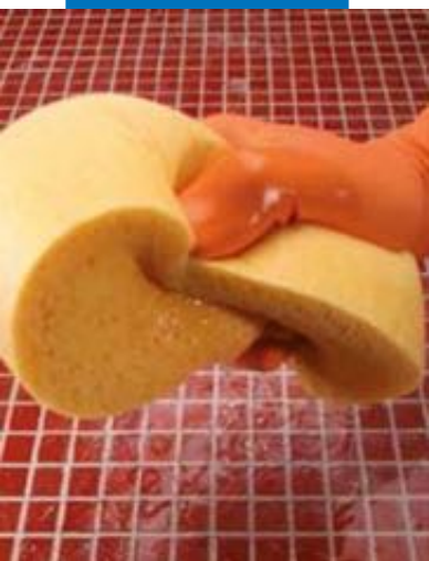
Смачивание поверхности перед очисткой
