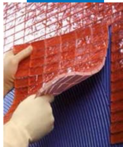
Укладка стеклянной мозаики с помощью Керароху Design на стены
