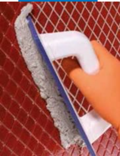
Нанесение Kerapoxy Design плоским резиновым шпателем
