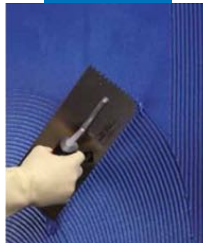
Нанесение Керароху Design синего цвета в качестве клея при помощи зубчатого шпателя
