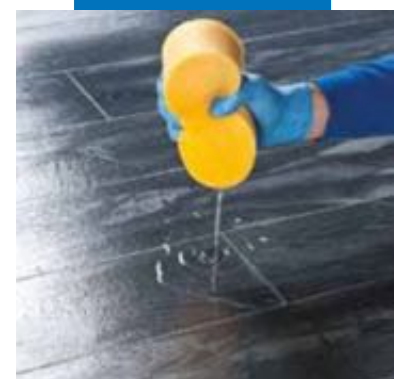
Смачивание поверхности перед очисткой
