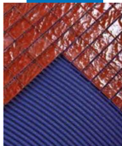
На следующий день, заполнение швов Керароху Design того же цвета, с соблюдением выше указанной процедуры заполнения швов
