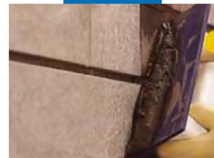
Заполнение швов на стене составом Ultracolor Plus с помощью резинового шпателя
