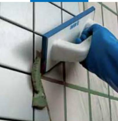
Заполнение швов на стене раствором Ultracolor Plus с помощью резинового шпателя
