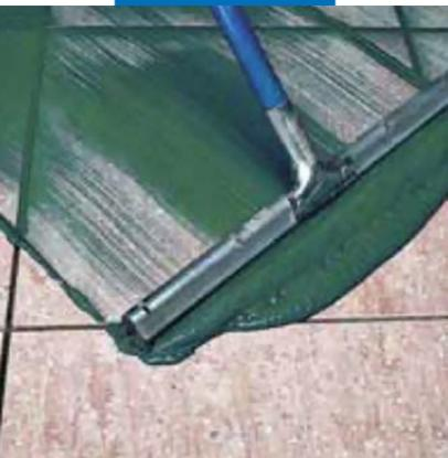
Заполнение швов на полу раствором Ultracolor Plus с помощью ракля с резиновым наконечником
